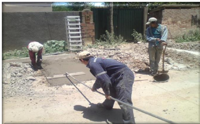
Fig.5.10. Texturizado del concreto mediante cepillo texturizador
