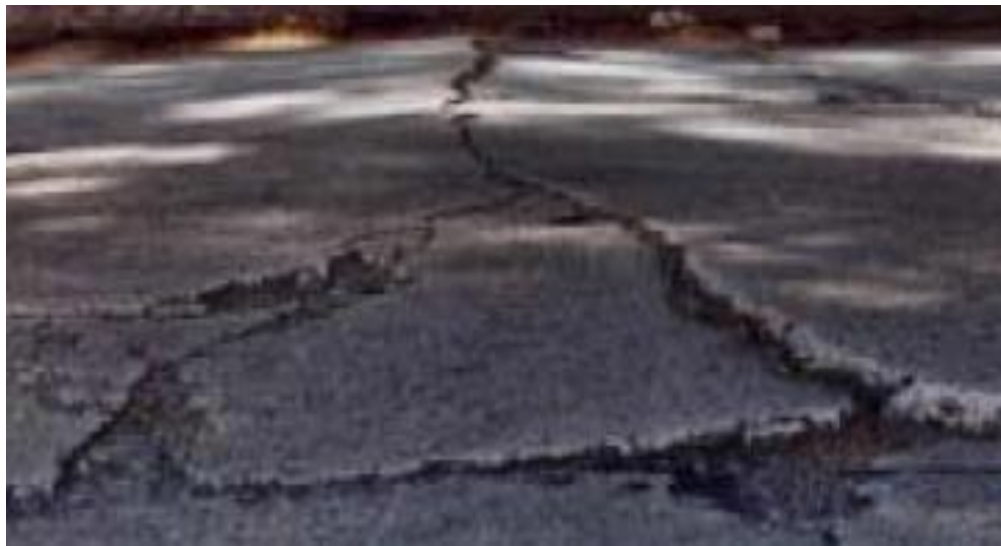
Fig.3.7. Levantamiento de Losas
