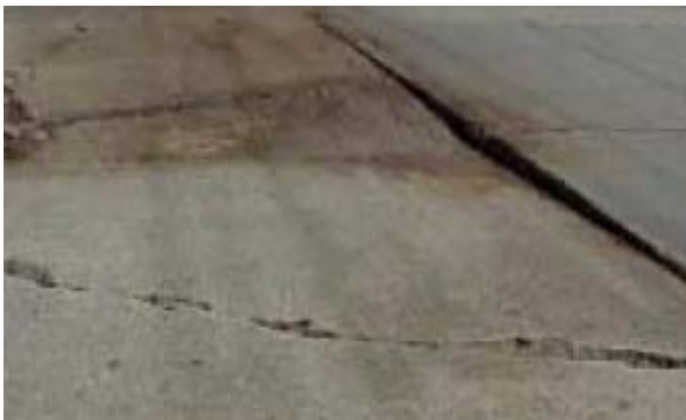
Fig.3.9. Hundimiento
