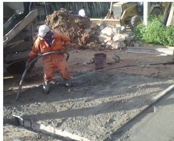
Fig. 5.9. Vibrado y enrasado
