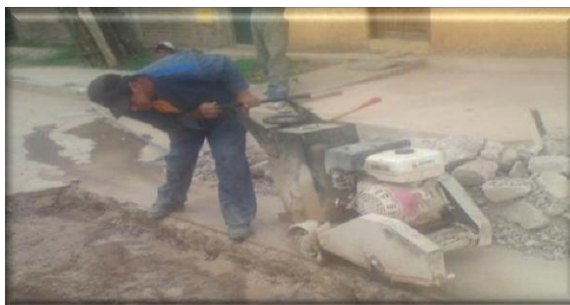
Fig.5.3. Aserrado de Bordes
