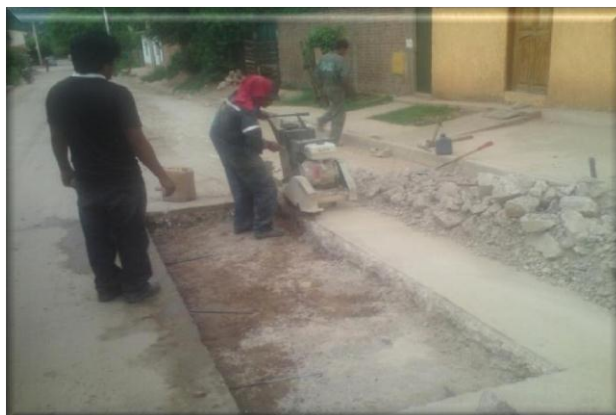
Fig.5.6. Reposición de las barras de amarre
