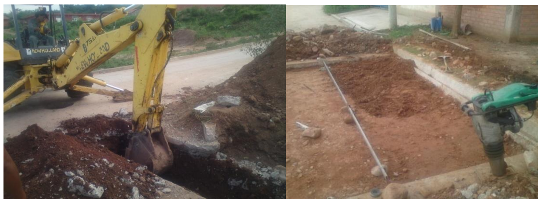
Extracción de material blando
