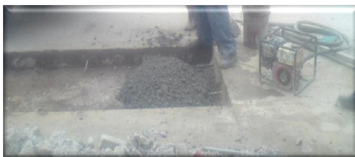
Fig.5.7. Verificación de dovelas en las vías de alto tráfico (Av. A Yacuiba y Av. A Tarija)
