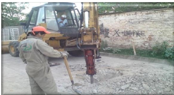
Fig.5.2. Demolición de losas con Martillo Hidráulico
