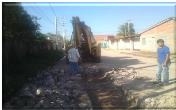
Fig.5.4. Limpieza del área demolida dejándola libre de materiales sueltos
