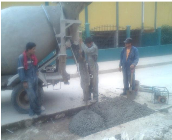
Fig. 5.8. Colocado del concreto diréctamente de la hormigonera
