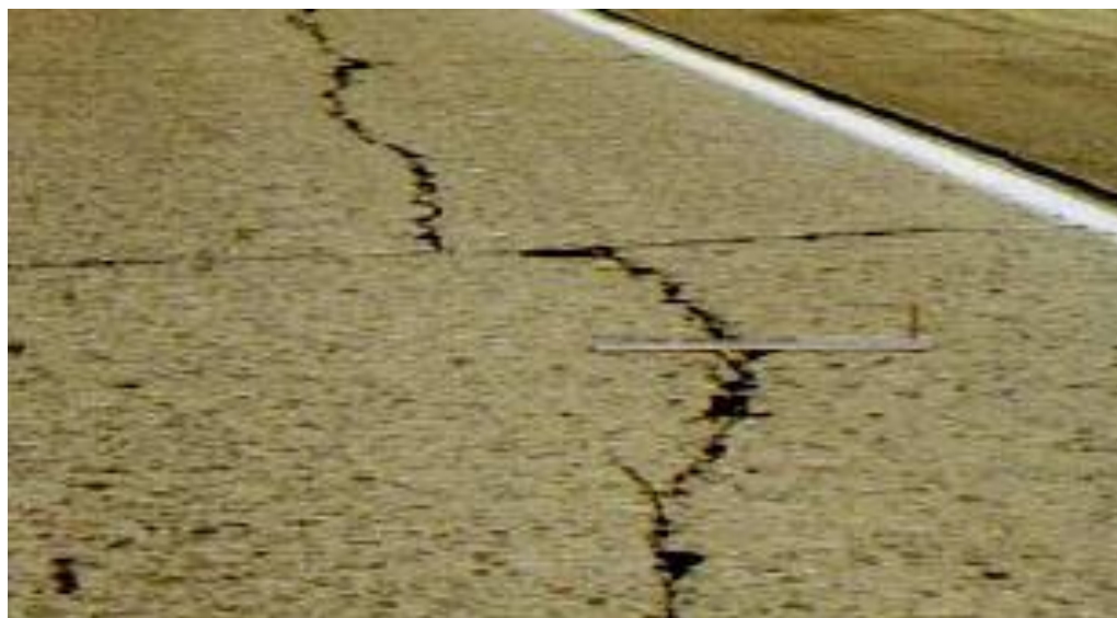
Fig.3.2. Fisura Longitudinal
