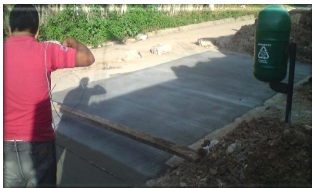
Fig.5.11. Losa terminada y lista para abrir al tráfico
