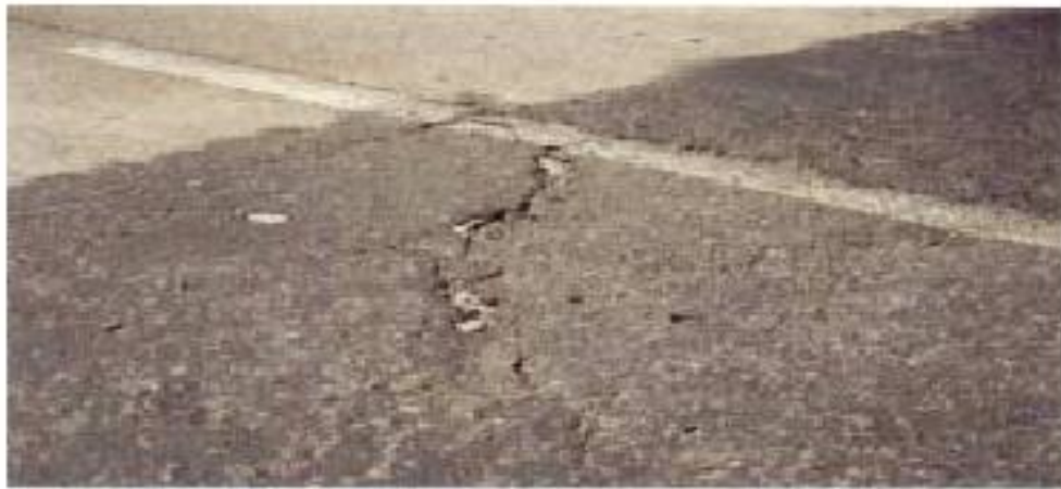
Fig.3.6. Fisuras Inducidas
