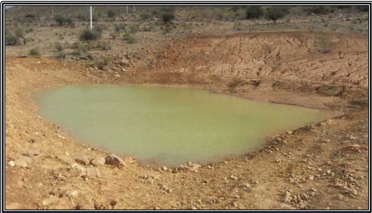
FIGURA 3.2.- Fotografía del reservorio sin impermeabilización.
