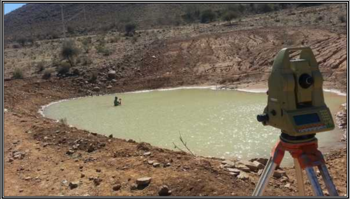
FIGURA 3.6.- Levantamiento topográfico del reservorio sin impermeabilización realizado con una estación total Leica.
