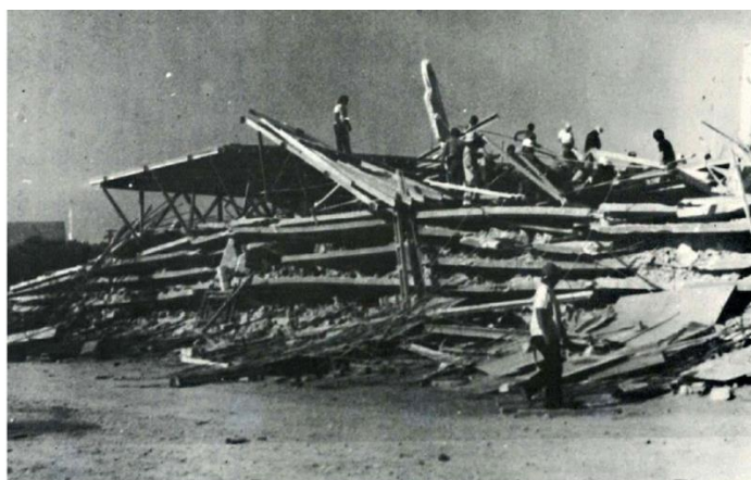
Fig.1.2 Colapso del edificio Harbour Cay Condominium en Florida, USA
