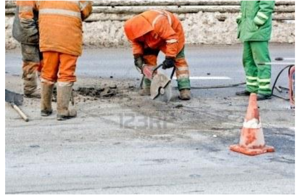
Figura 2. 10 Demolición mecánica
