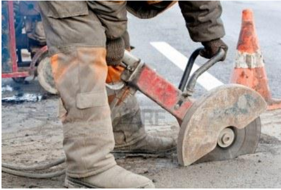
Figura 2. 9 Demolición mecánica
