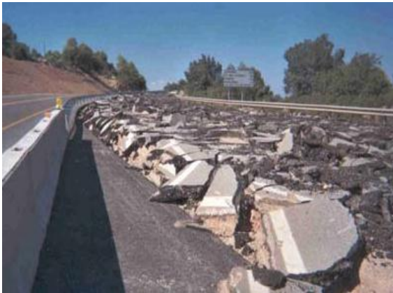
Figura 2. 7 Demolición mecánica
