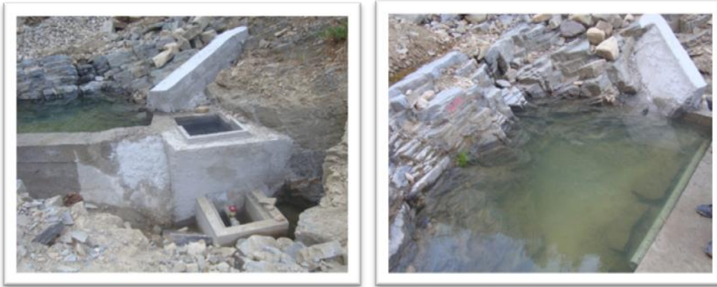
Figura 2.3. Protección de Vertiente tipo bofedal
