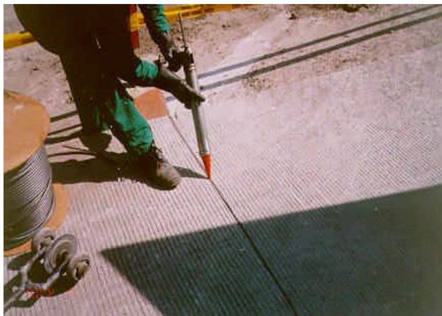
- ILUSTRACIÓN 15 SELLADO DE JUNTAS
