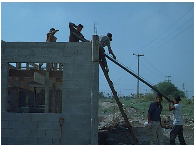
Figura 2: Alzado de viguetas en obra
