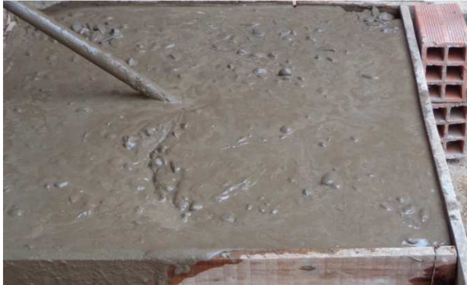
Figura 52: Vibrado del hormigón por el área.
