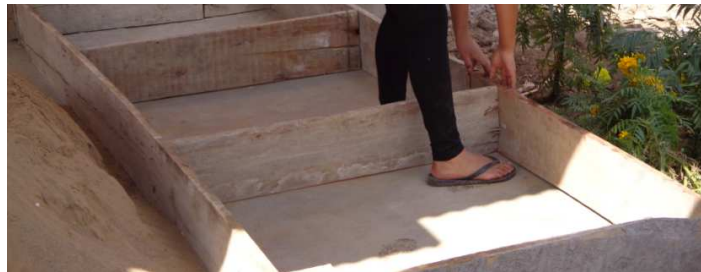
Figura 36: Asegurando el encofrado.
