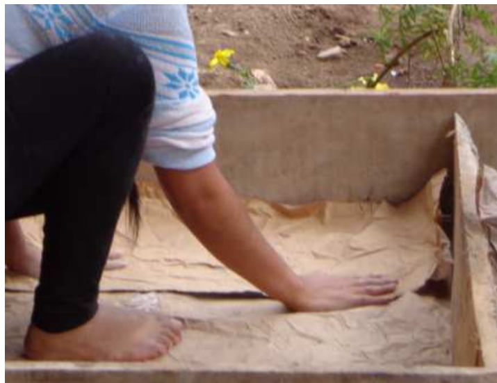
Figura 39: Colocando el material antiadherente (bolsa de cemento).
