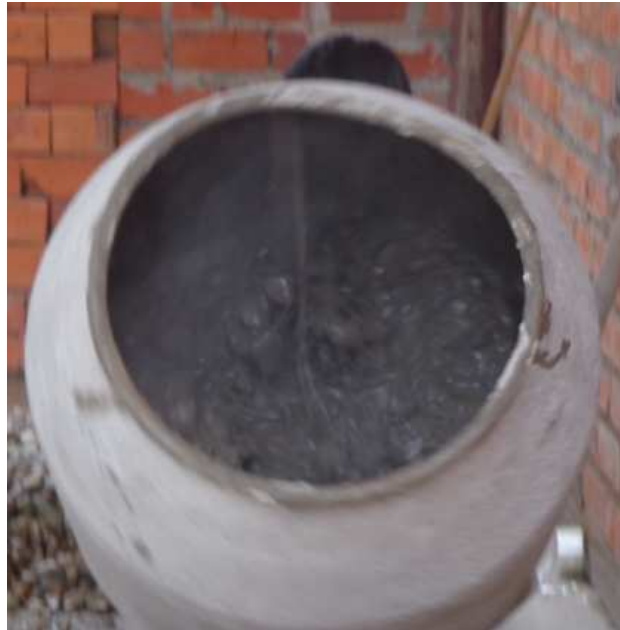
Figura 46: Mezcla completa de los materiales del hormigón.
