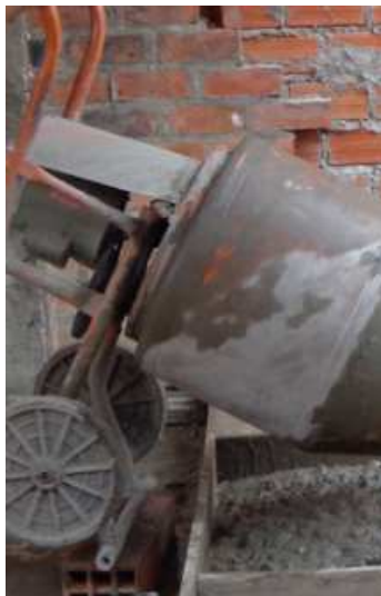
Figura 54: Vaciado de la losa 2.
