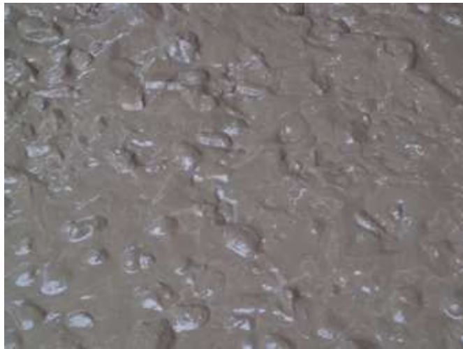
Figura 50: Encofrado lleno con hormigón.
