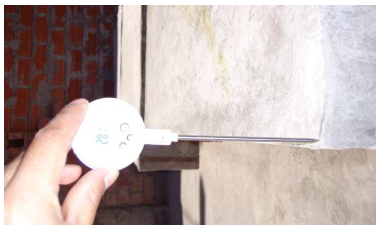
Figura 60: Lectura de temperatura en la esquina de la losa.
