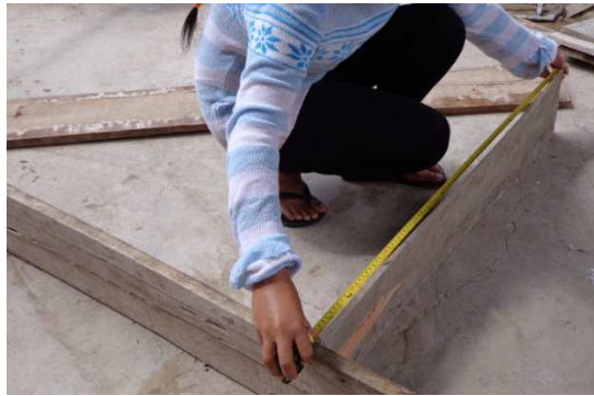
Figura 35: Dimensiones del encofrado.
