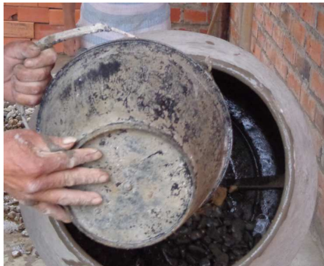
Figura 43: Vaciado del agregado grueso a la mezcladora.
