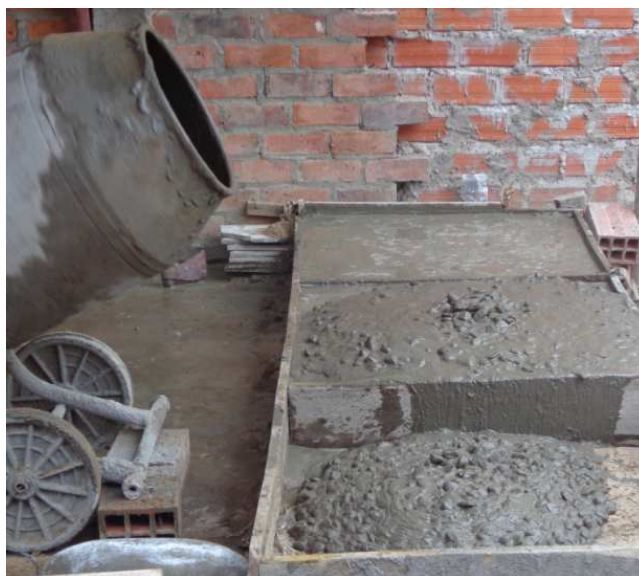
Figura 57: Hormigón en encofrado para la tercera losa.
