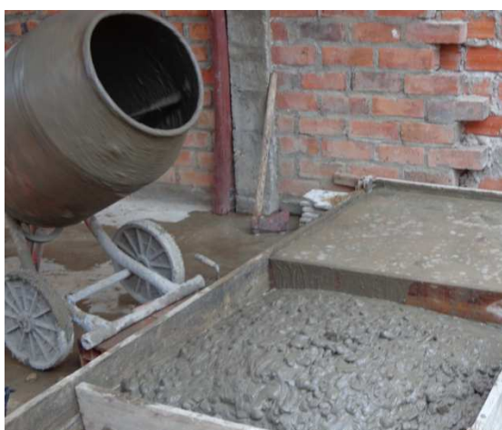
Figura 55: Llenando del encofrado para losa 2.
