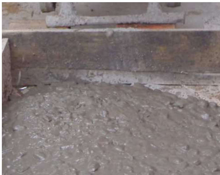
Figura 49: Llenando encofrado con hormigón.
