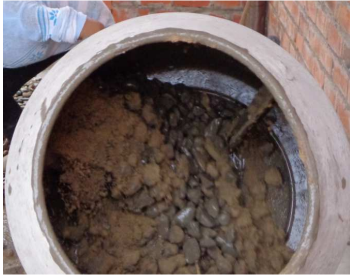
Figura 44: Agregados y agua en la mezcladora.
