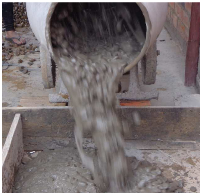
Figura 47: Vaciando hormigón al encofrado.
