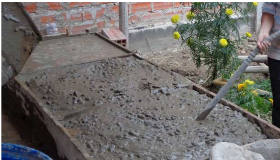
Figura 58: Vibrado de la tercera losa.
