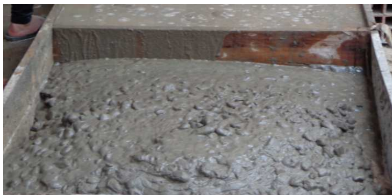
Figura 56: Hormigón en encofrado para losa 2.
