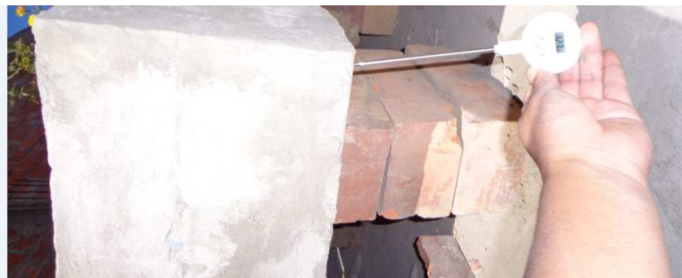
Figura 64: Lectura de temperatura en la esquina de la losa en la cara inferior.
