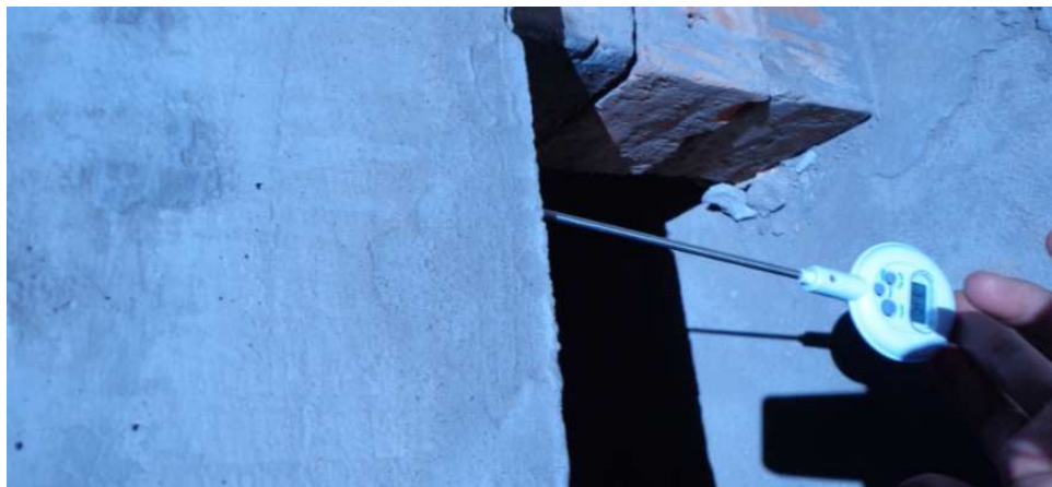
Figura 62: Lectura de temperatura en el borde de la cara inferior de la losa.
