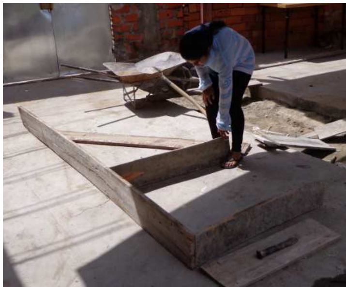
Figura 34: Encofrado.
