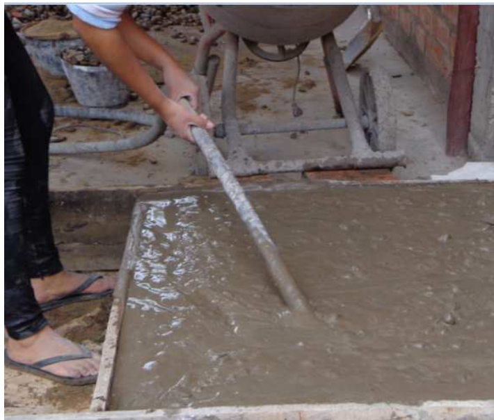
Figura 51: Vibrado del hormigón.
