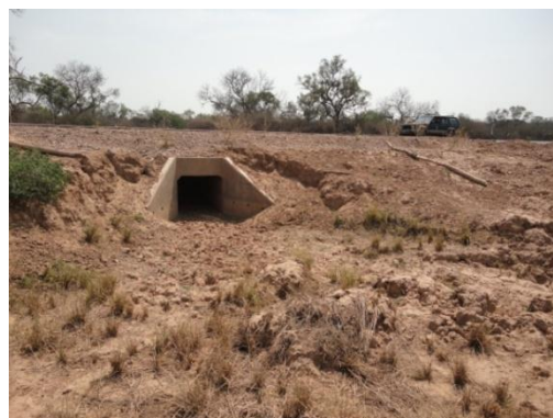
Salida de alcantarilla
