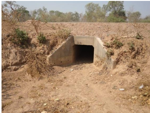
Entrada de la alcantarilla:
