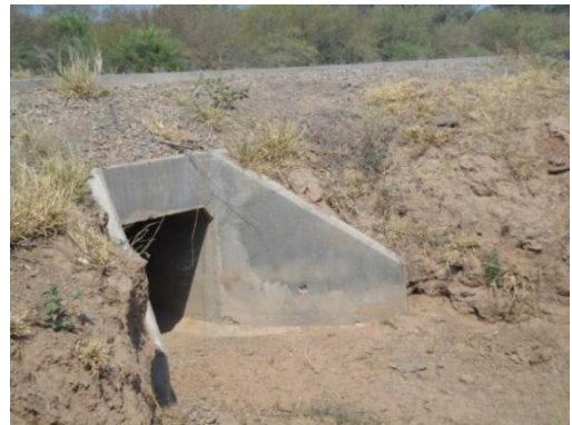
Salida de alcantarilla
