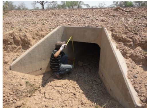
Salida de alcantarilla
