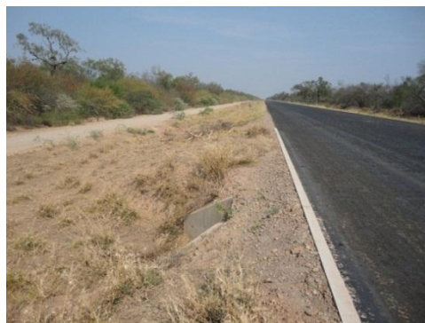
Salida de alcantarilla
