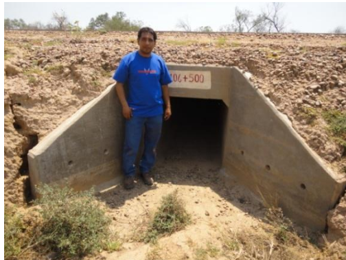
Entrada de la alcantarilla:
