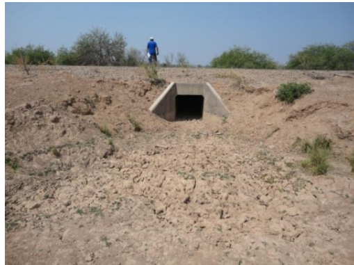
Entrada de la alcantarilla:
