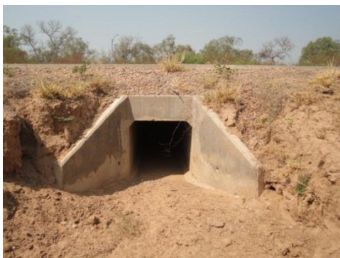
Entrada de la alcantarilla:
