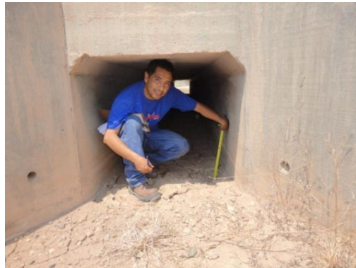
Entrada de la alcantarilla:
