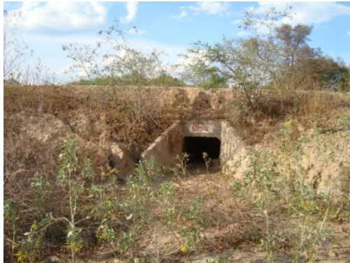
Entrada de la alcantarilla:
