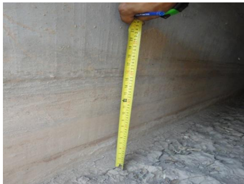
Entrada de la alcantarilla:
