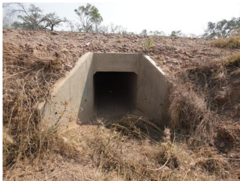
Entrada de la alcantarilla:
