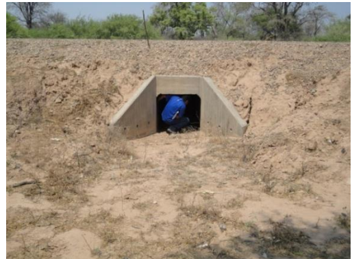
Salida de alcantarilla
