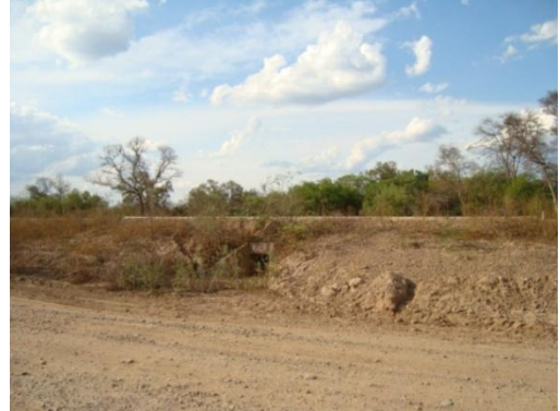
Salida de alcantarilla
