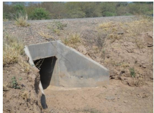
Salida de alcantarilla
