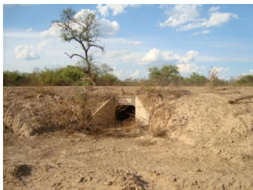
Entrada de la alcantarilla:
