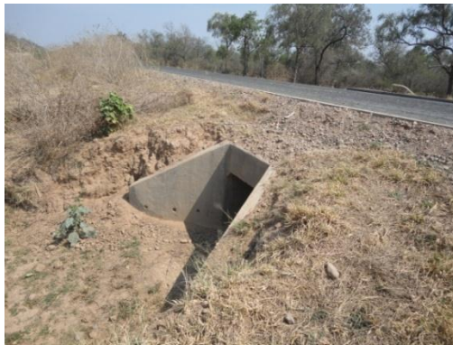
Entrada de la alcantarilla:
