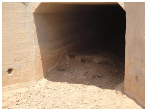
Salida de alcantarilla
