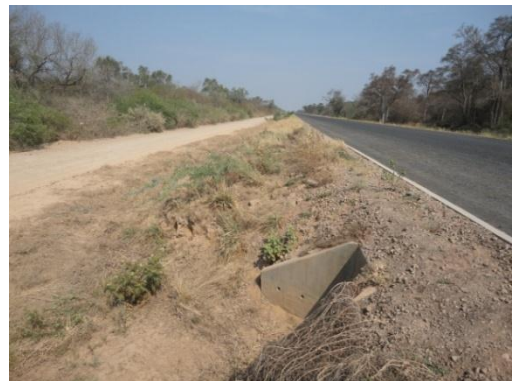
Salida de alcantarilla
