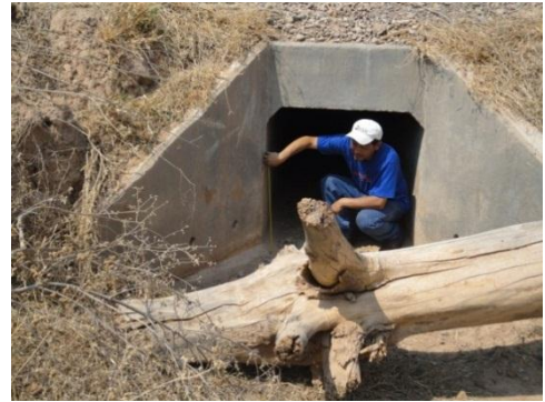
Salida de alcantarilla
