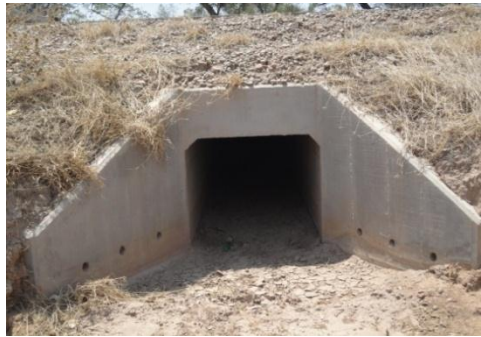
Entrada de la alcantarilla:
