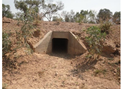
Salida de alcantarilla
