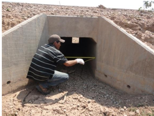
Entrada de la alcantarilla:
