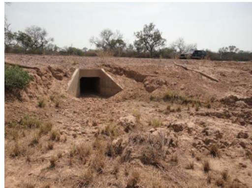
Salida de alcantarilla
