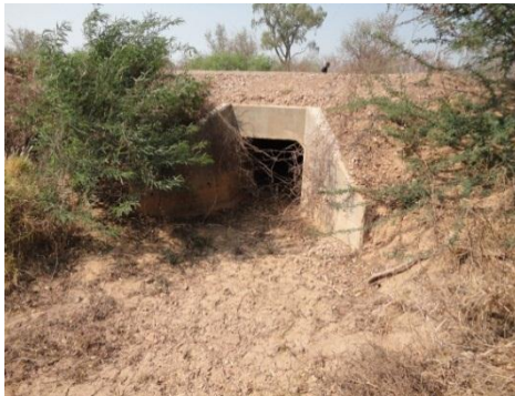
Entrada de la alcantarilla:
