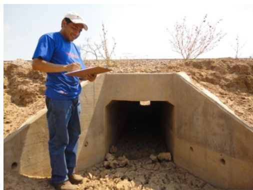
Entrada de la alcantarilla:
