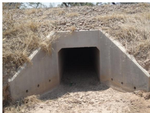
Salida de alcantarilla
