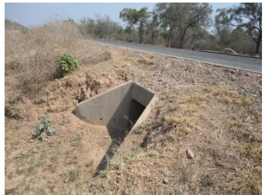
Salida de alcantarilla
