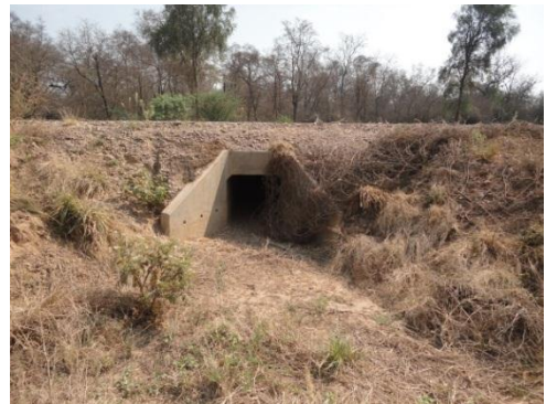
Salida de alcantarilla
