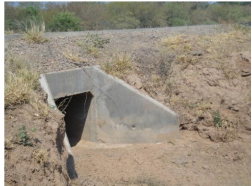
Salida de alcantarilla
