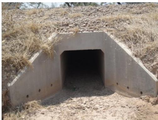
Entrada de la alcantarilla:
