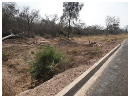
Entrada de la alcantarilla:
