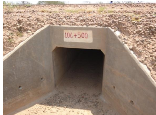
Salida de alcantarilla
