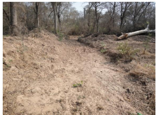
Salida de alcantarilla
