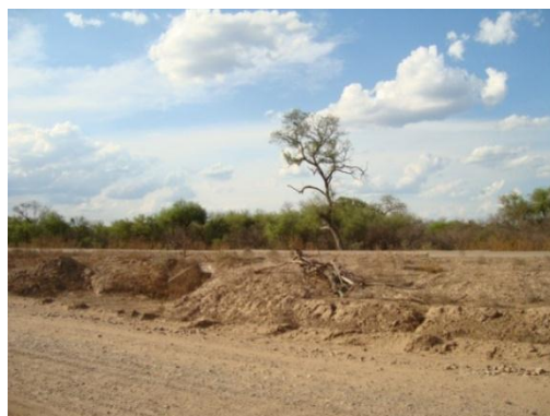
Salida de alcantarilla
