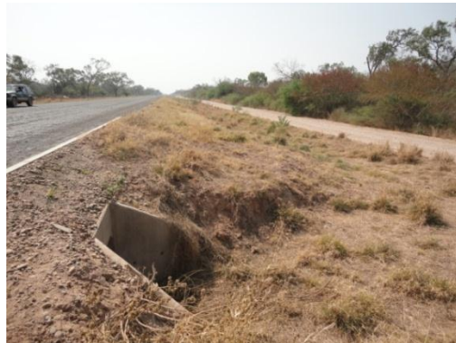
Entrada de la alcantarilla:
