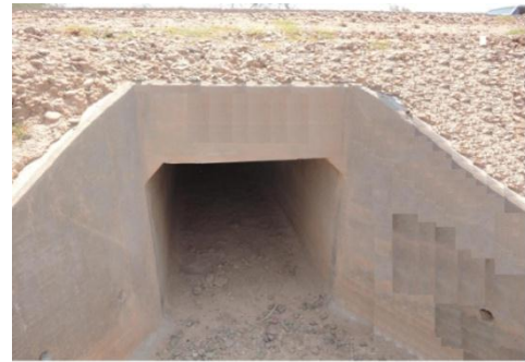
Salida de alcantarilla
