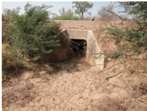
Entrada de la alcantarilla:
