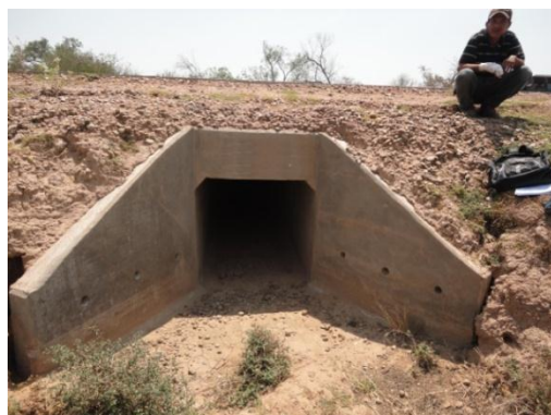
Entrada de la alcantarilla:
