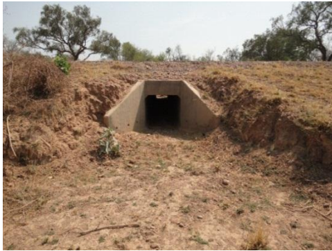
Entrada de la alcantarilla:
