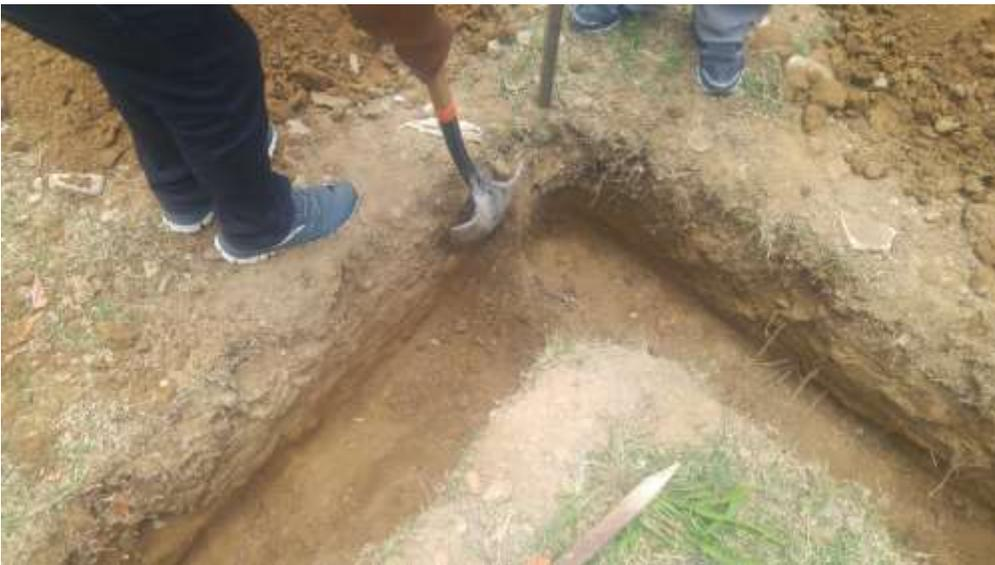
Fig. 7 .3 Excavación cimiento de 40 cm de ancho en ángulo
