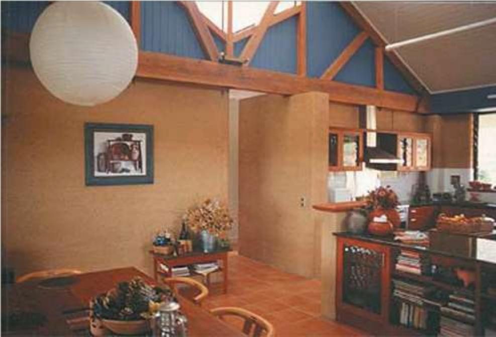
Fig.1.2.6 Foto: tierra apisonada Construcciones Pty Ltd
