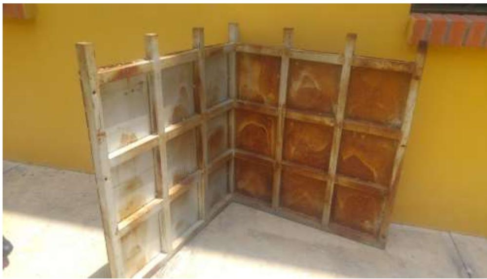
Fig. 7 Molde en mal estado
