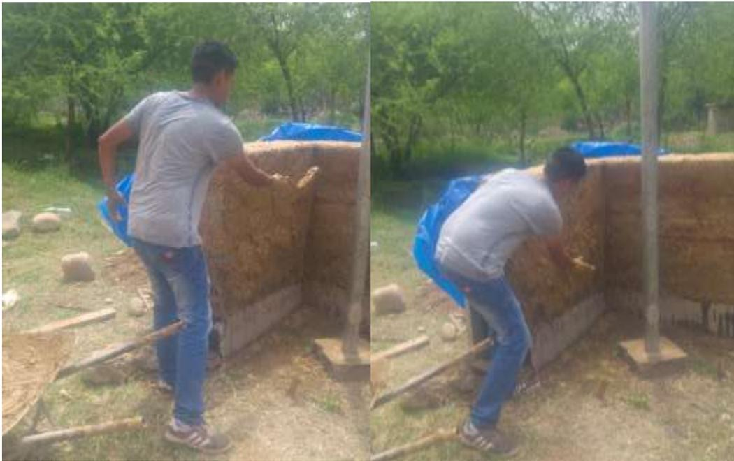
Fig. 8.7 Chicoteado de muro
