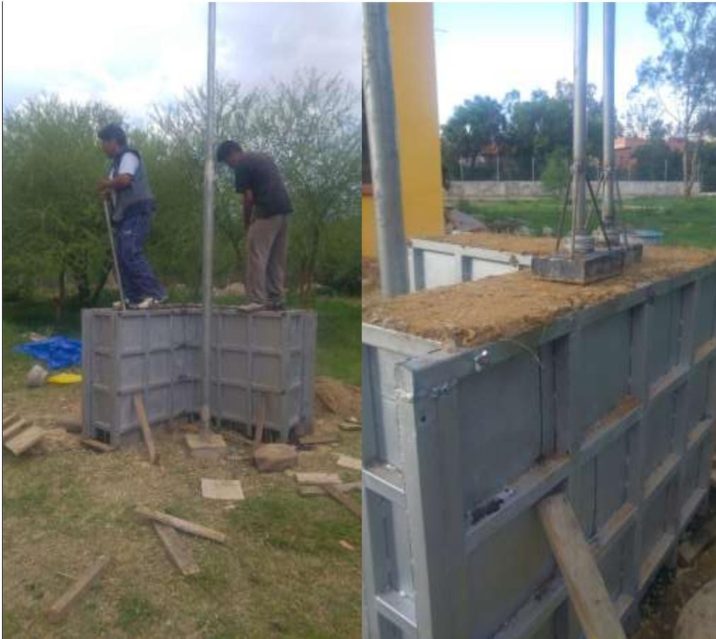
Fig. 8.2 Finalización de muro de tapial
