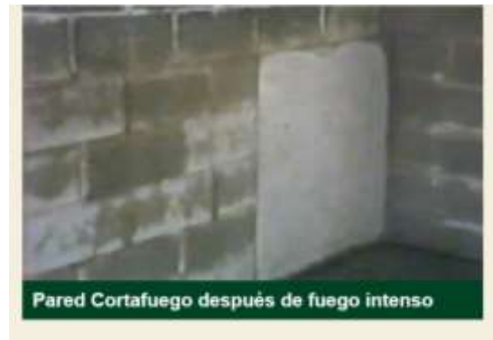
Pared Cortafuego después de fuego intenso
