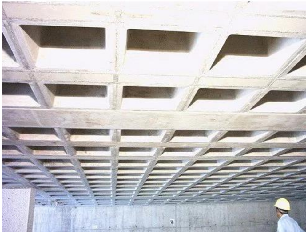
Figura 4.2 Losa casetonada o reticular
