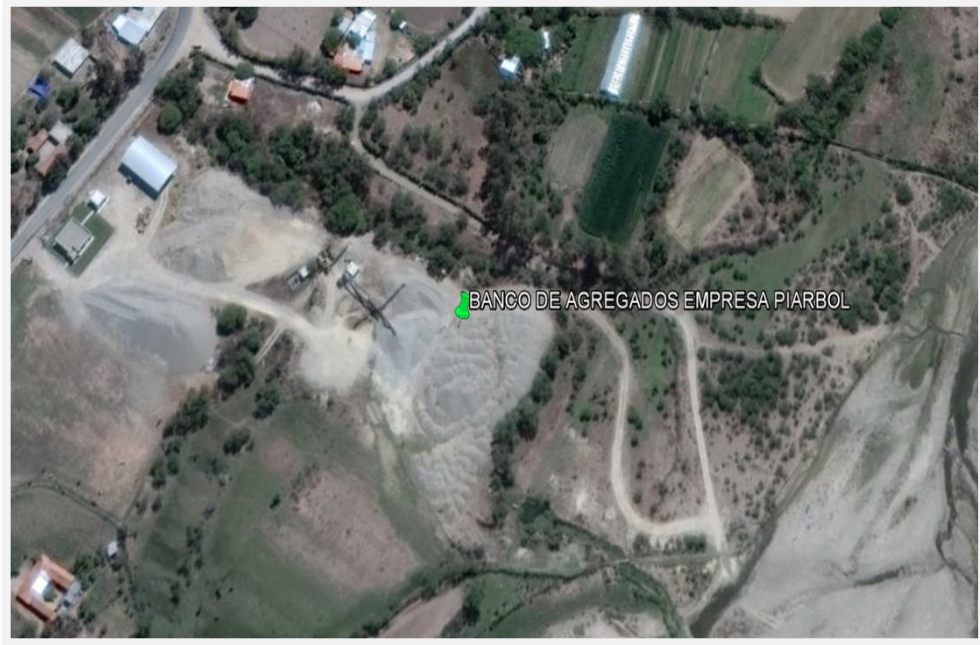
Figura 10. Ubicación la planta chancadora de la empresa constructora “PIARBOL S.R.L.”.
