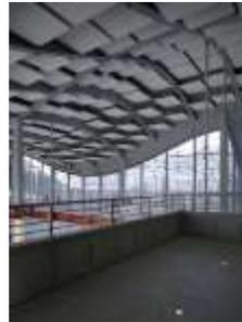
Por las formas rectangulares que se generan en las plantas de los bloques la estructura es tradicional siguiendo una grilla cuadriculada. Los patios inferiores tienen anexas con columnas. Se identifican columnas esbeltas de acero de gran resistencia; la estructuración de las esferas está conformada de sistemas de arcos catenarios.
