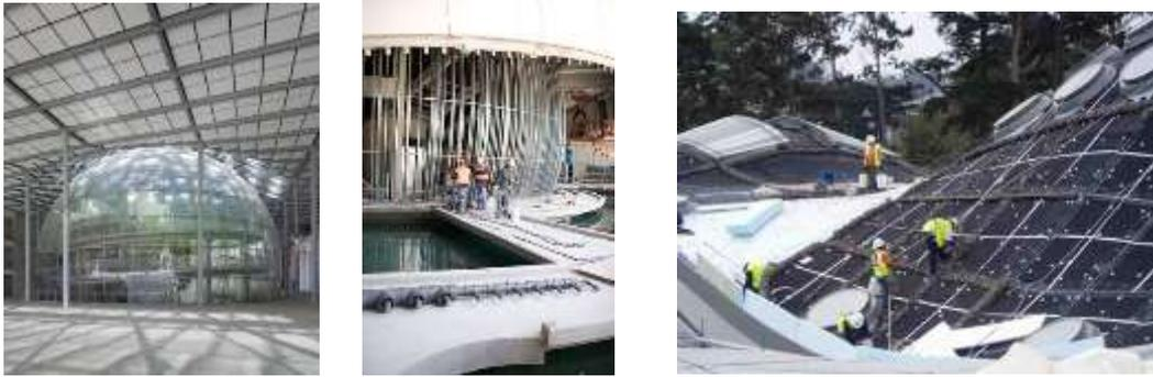
Se identifican columnas esbeltas de acero de gran resistencia; la estructuración de las esferas está conformada de sistemas de arcos catenarios.
