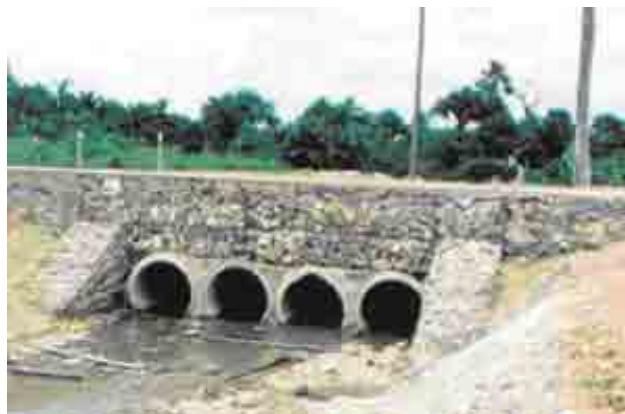
Fotografía 3: Batería de alcantarillas circulares de tubos de hormigón armado.
