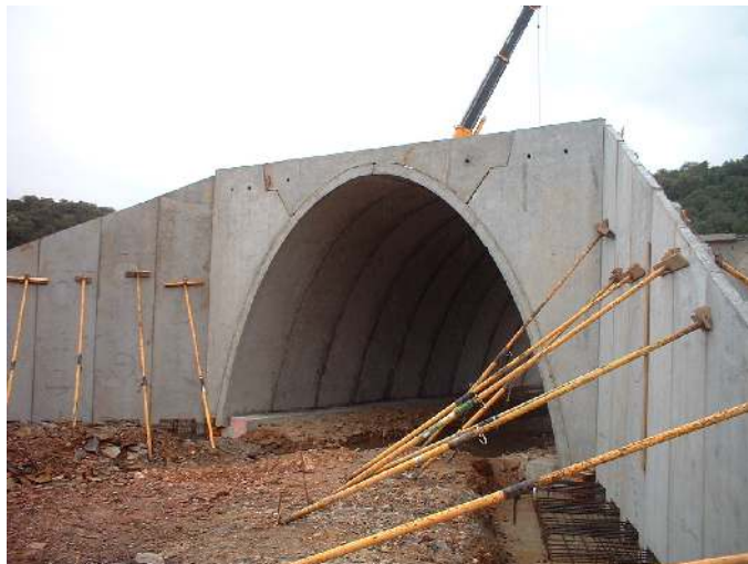
Fotografía 5: Alcantarillas tipo bóveda.
