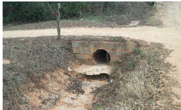
Fotografía 1: Alcantarilla lateral.
