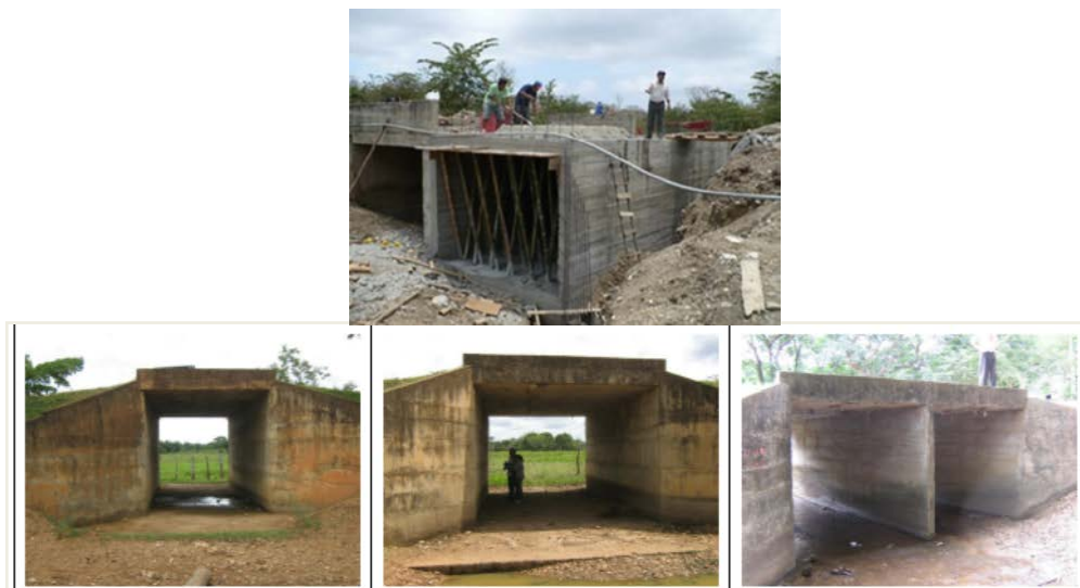
Fotografía 4: Alcantarillas tipo cajón de hormigón armado.
