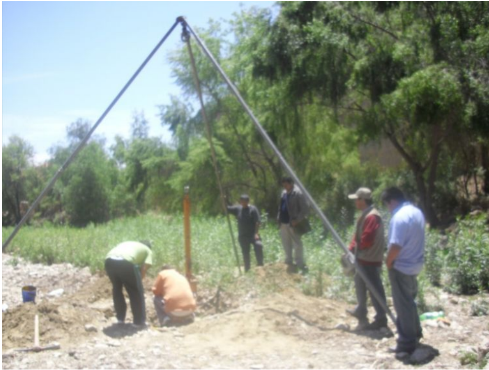
Fotografía 5 Ensayo de SPT equipo de Laboratorio de Mecánica de Suelos.
