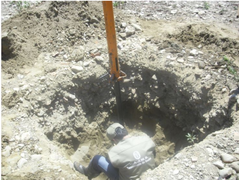
Fotografía 6 Operario de laboratorio de Suelos Manipulando el Equipo SPT.
