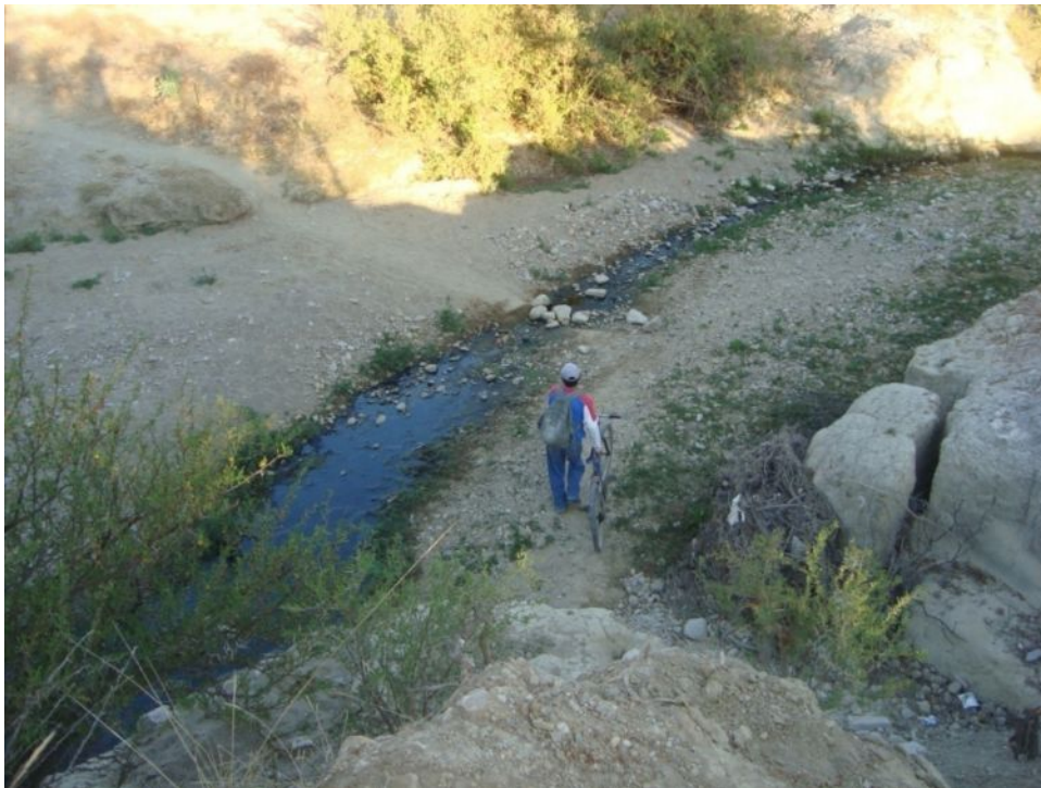
Fotografía 2 Vista de la Quebrada Sagredo (Lugar donde se emplazará el puente)
